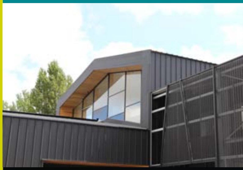
RENTRÉE 2017 : NOUVEAU CAMPUS
